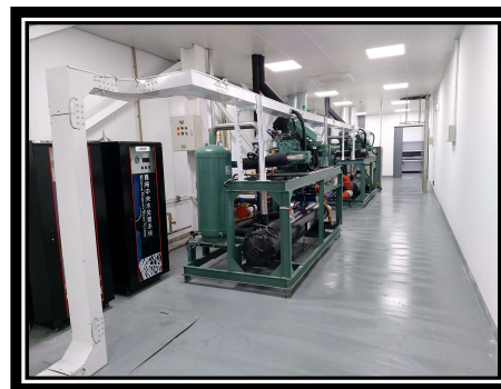
复叠螺杆压缩机（比泽尔）冷冻机组
