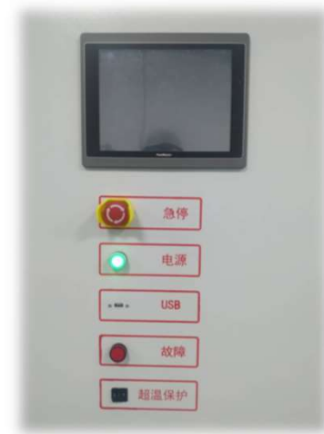
箱体控制面板（急停开关、超温保护，通讯接口等）
